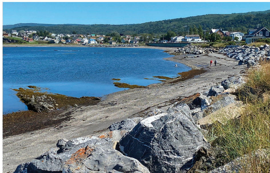
De l'enrochement a déjà été fait dans le secteur à l'est du quai, derrière la caisse Desjardins de Sainte-Anne-des-Monts.
