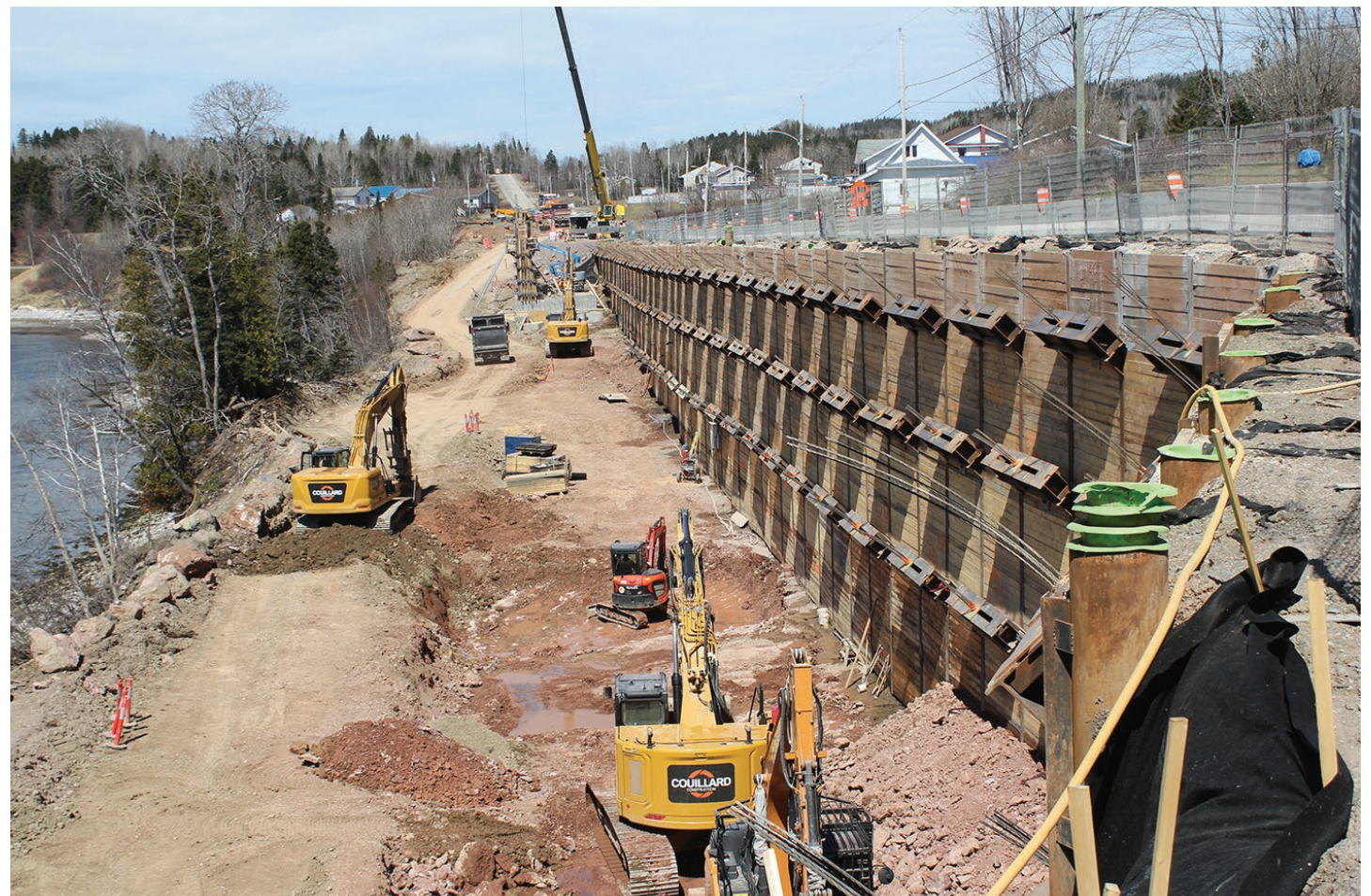
Les travaux majeurs de réfection de l'emprise ferroviaire auraient coûté beaucoup moins cher s'ils avaient débuté il y a 10 ans. On voit ici la construction d'un mur de soutènement à Port-Daniel.
