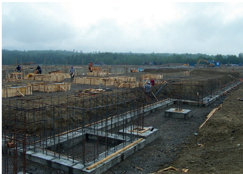
Le chantier de construction au tout début de l'aventure, à la mi-juillet 2005, réalisé par LFG Construction de Carleton-sur-Mer.
