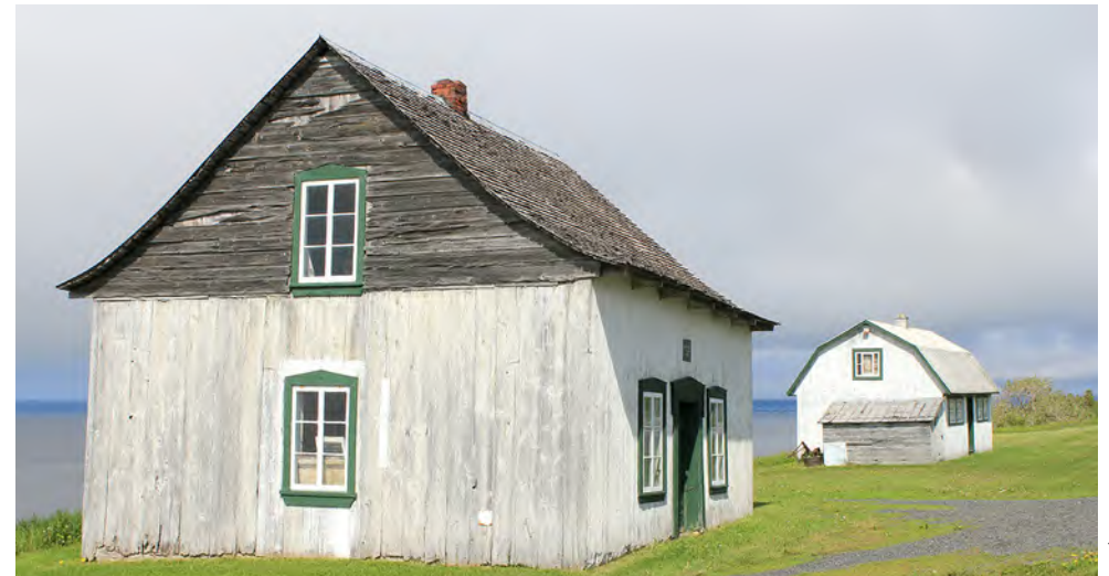
Des gens arrêtent tous les jours pour photographier cet ensemble plutôt unique, qui s'est même retrouvé sur un calendrier à Québec.
