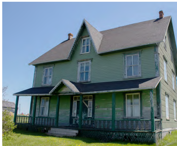
La Maison LeGros recèle des éléments architecturaux originaux.
